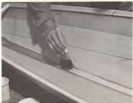
15. Glassfibre taping the keel.
